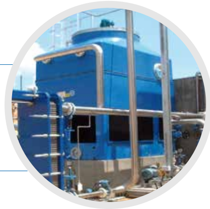
Instalación torre de refrigeración
